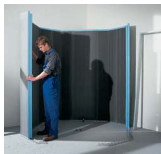
Монтаж на металлические направляющие с помощью системы пазов и пружин.
